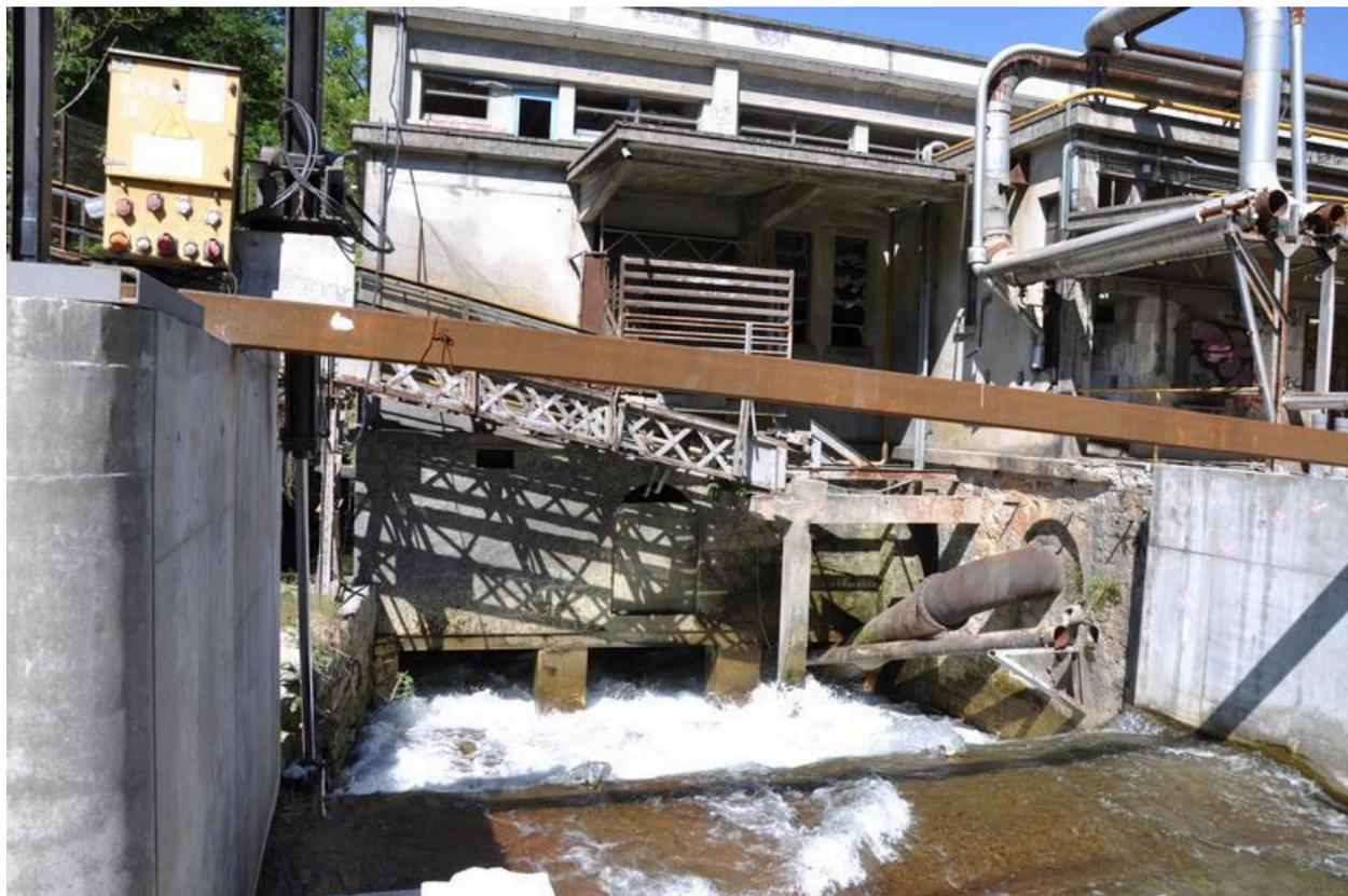
Détail du seuil du barrage de la papeterie de Cran et d'une des conduites forcée.
