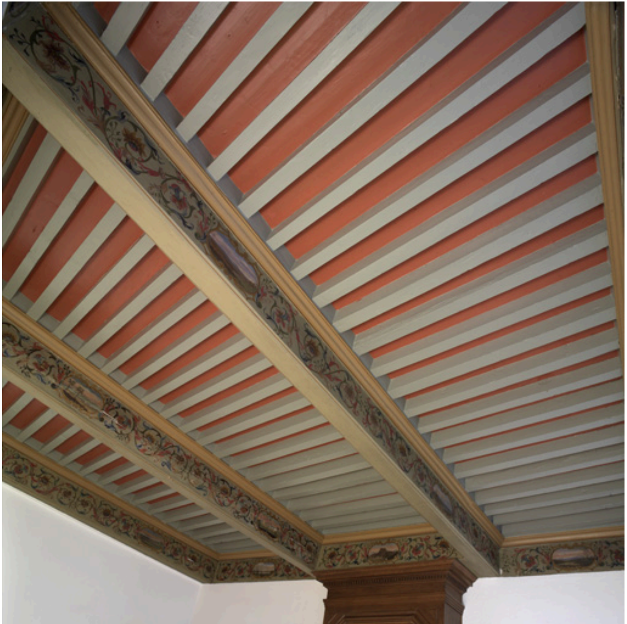
Vue partielle du plafond.
