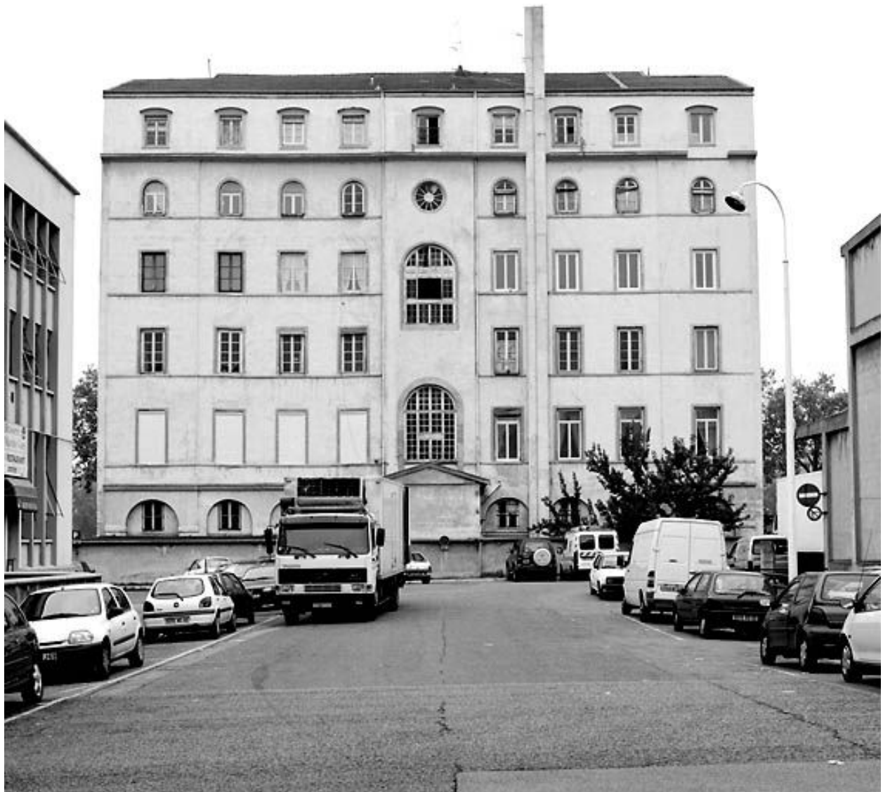
Elévation postérieure depuis le marché de gros
