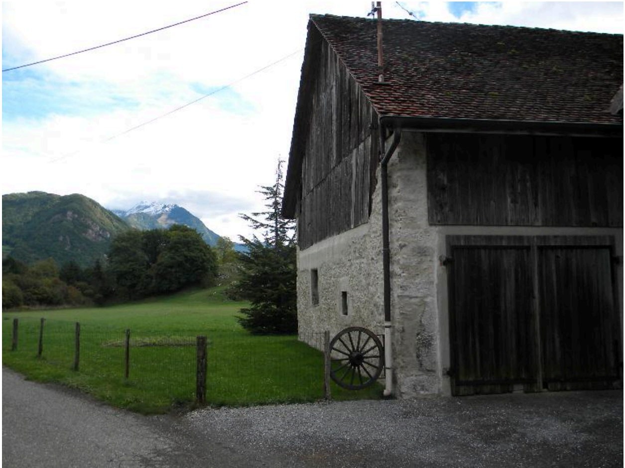
Vue de la partie nord-ouest du bâtiment
