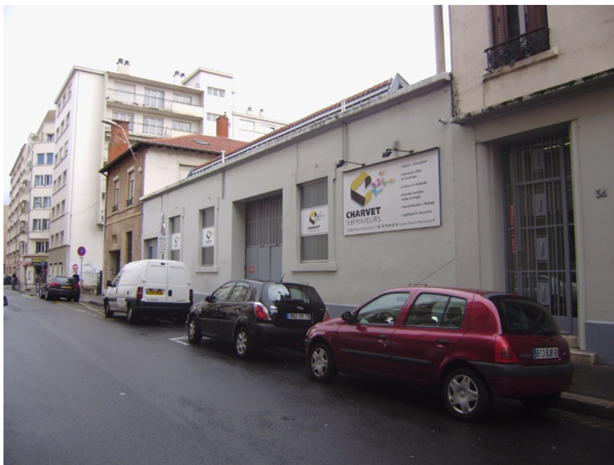
Façade ateliers vue ouest
