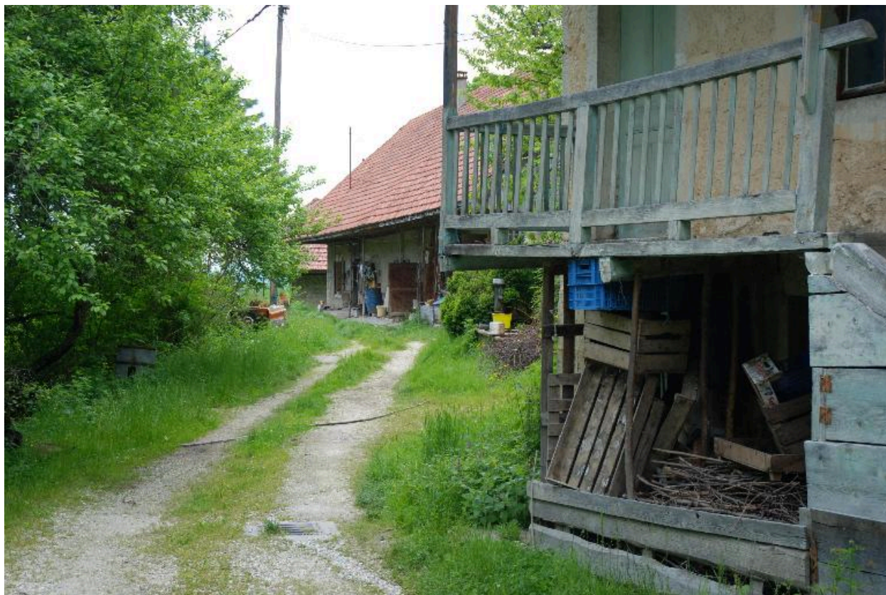
Détail de l'escalier extérieur et vue vers la ferme voisine.
