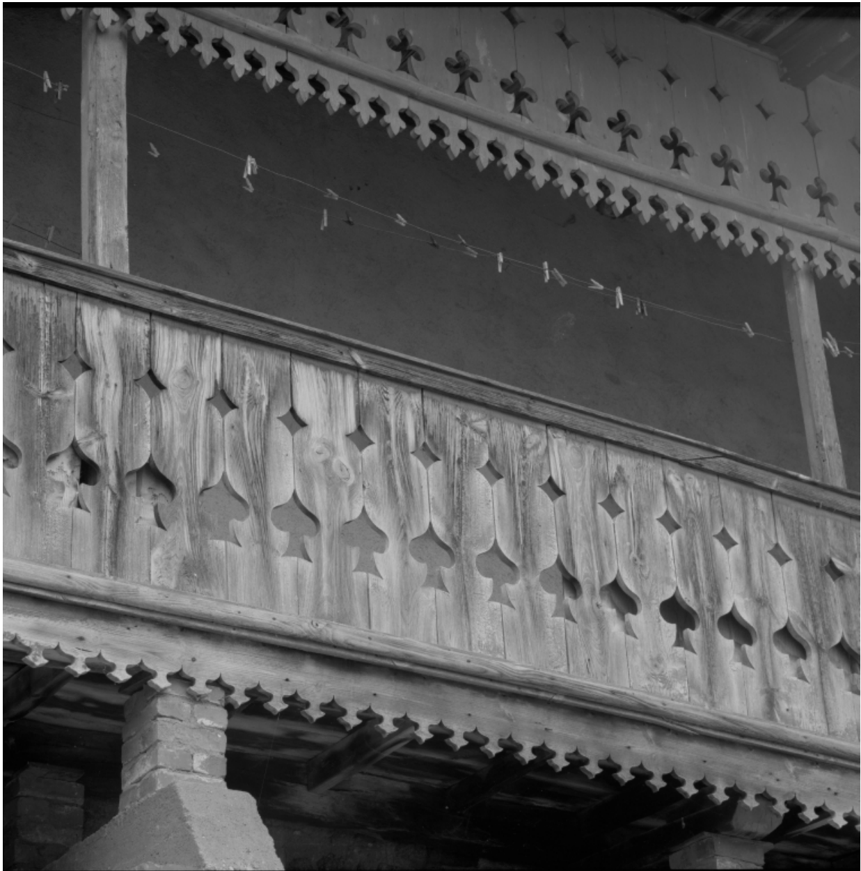
Ferme construite à la fin du 19e siècle. Vue latérale gauche du logis avec détail des bois découpés de la galerie.
