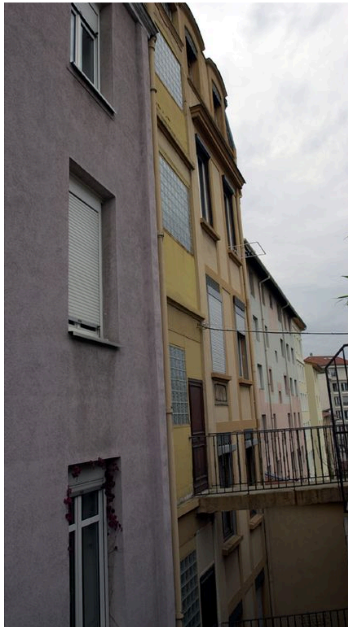
Elévation postérieure, vue latérale
