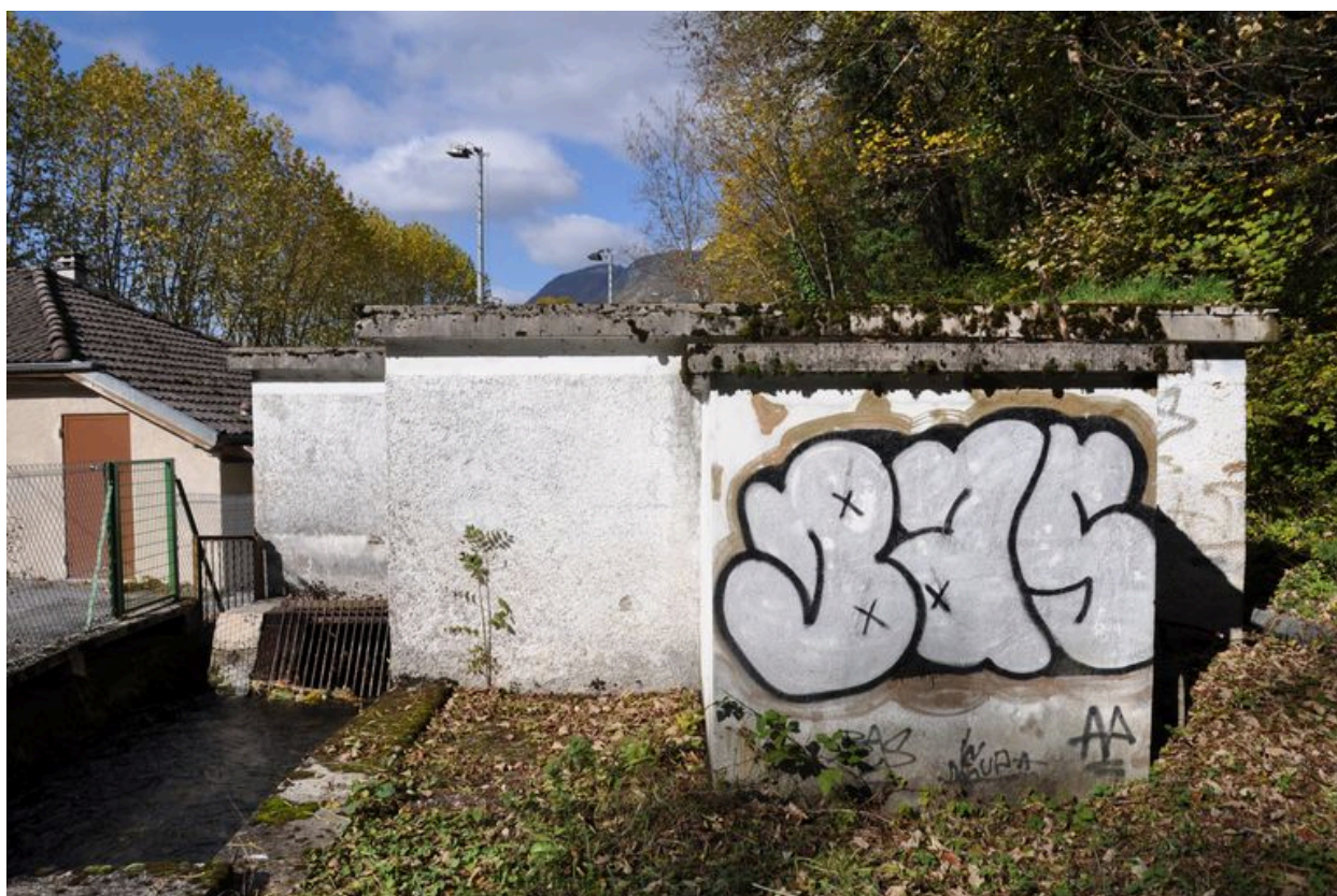
Vue de la façade postérieure de la seconde micro-centrale de la Curiale
