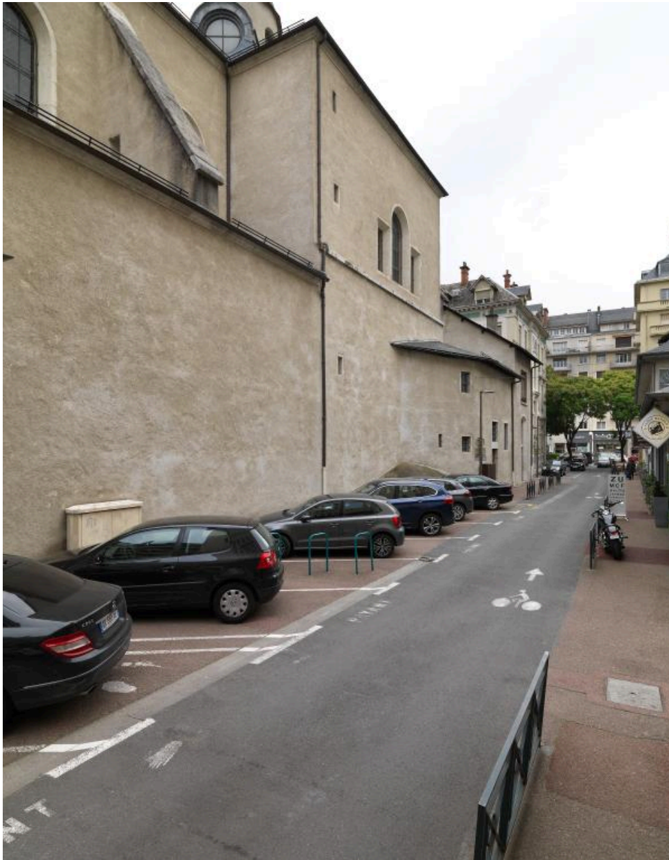
Vue partielle du flanc sud depuis l'ouest
