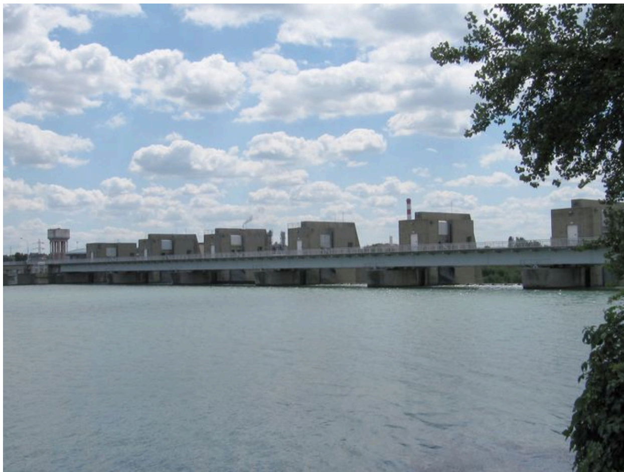
Vue générale du barrage, face amont (depuis la rive droite)
