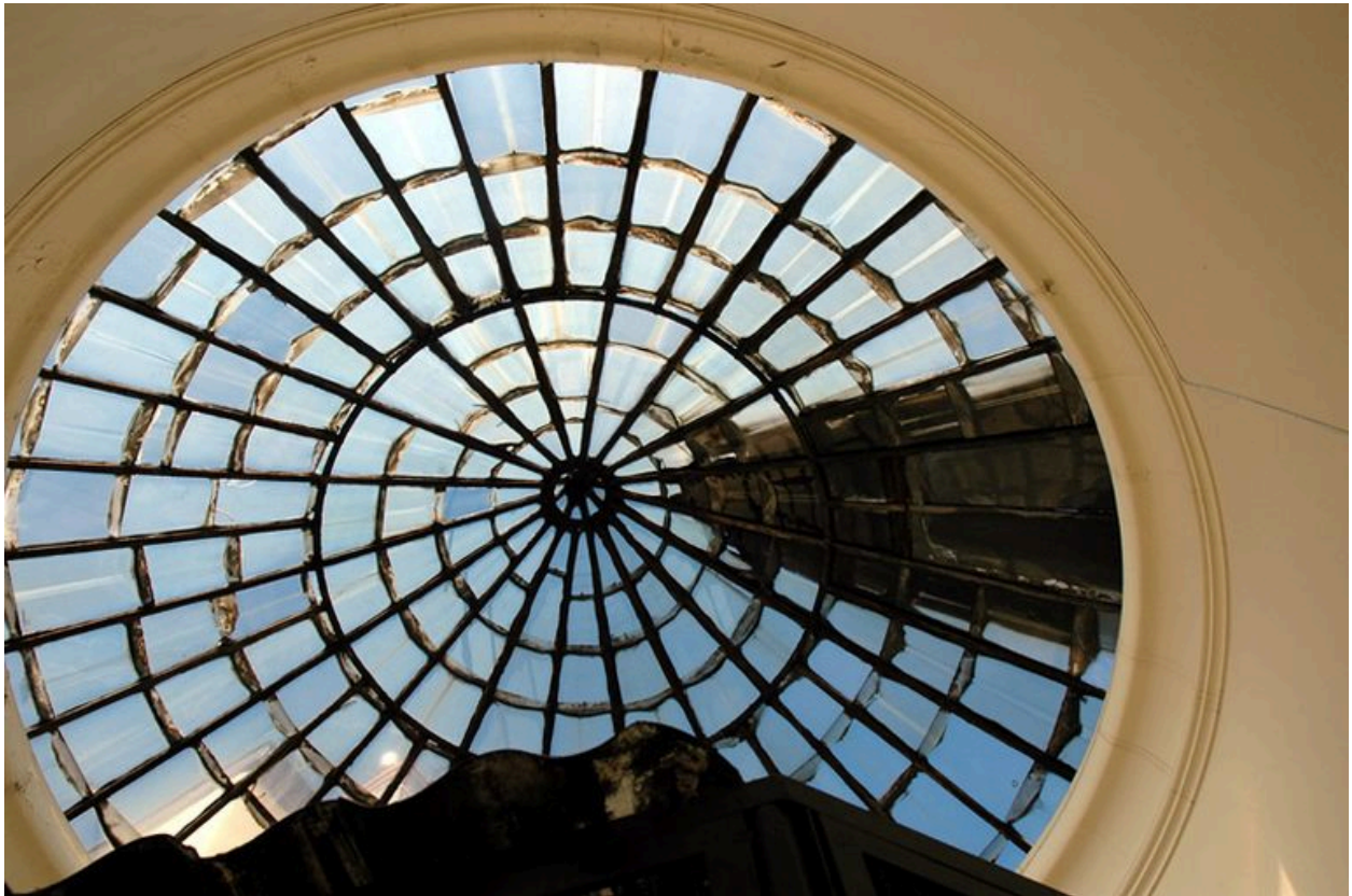
La cage d'escalier : le "ciel ouvert"
