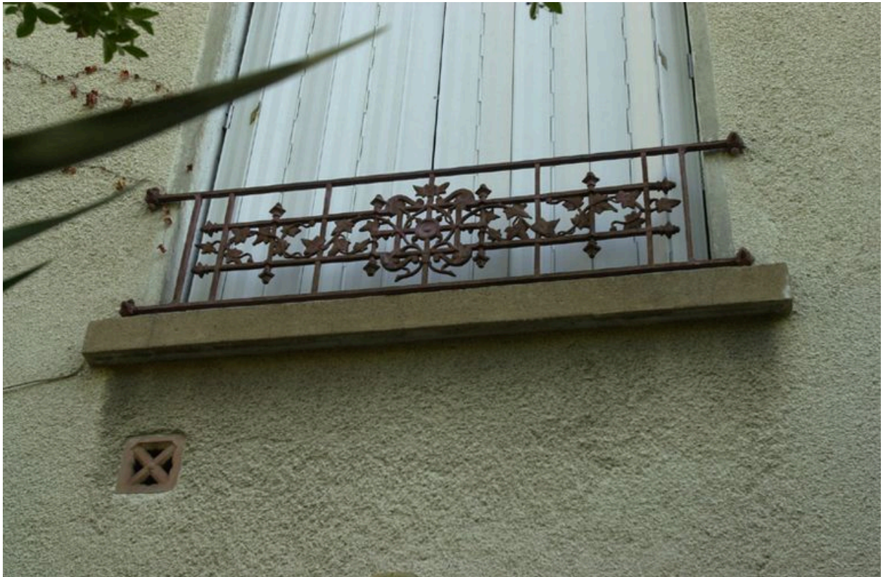
Détail d'un garde-corps du corps de bâtiment sud
