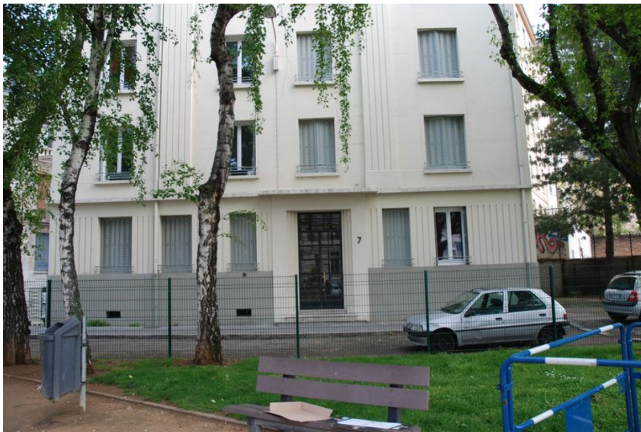
Façade est, détail des trois premiers niveaux
