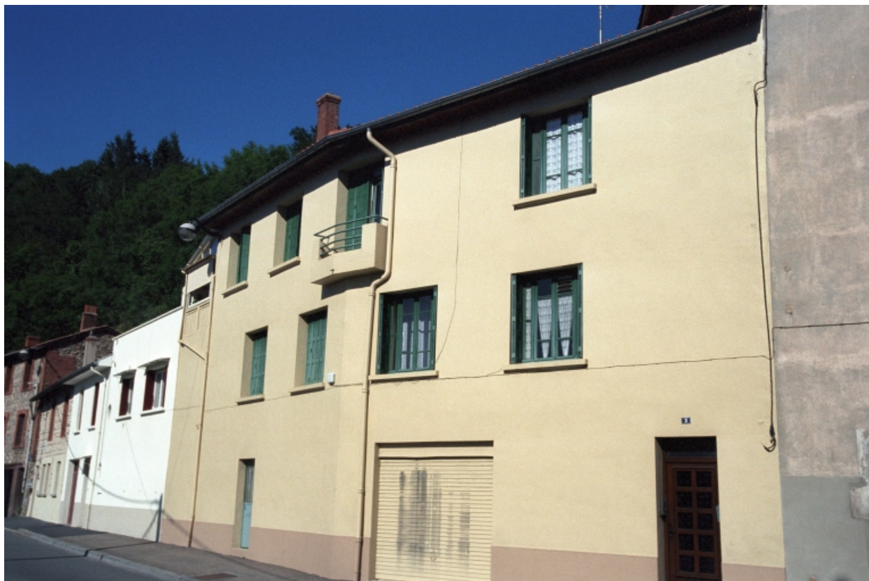
Boën, îlot 11, Clermont (rue de) 3. Vue générale de la façade sur rue.
