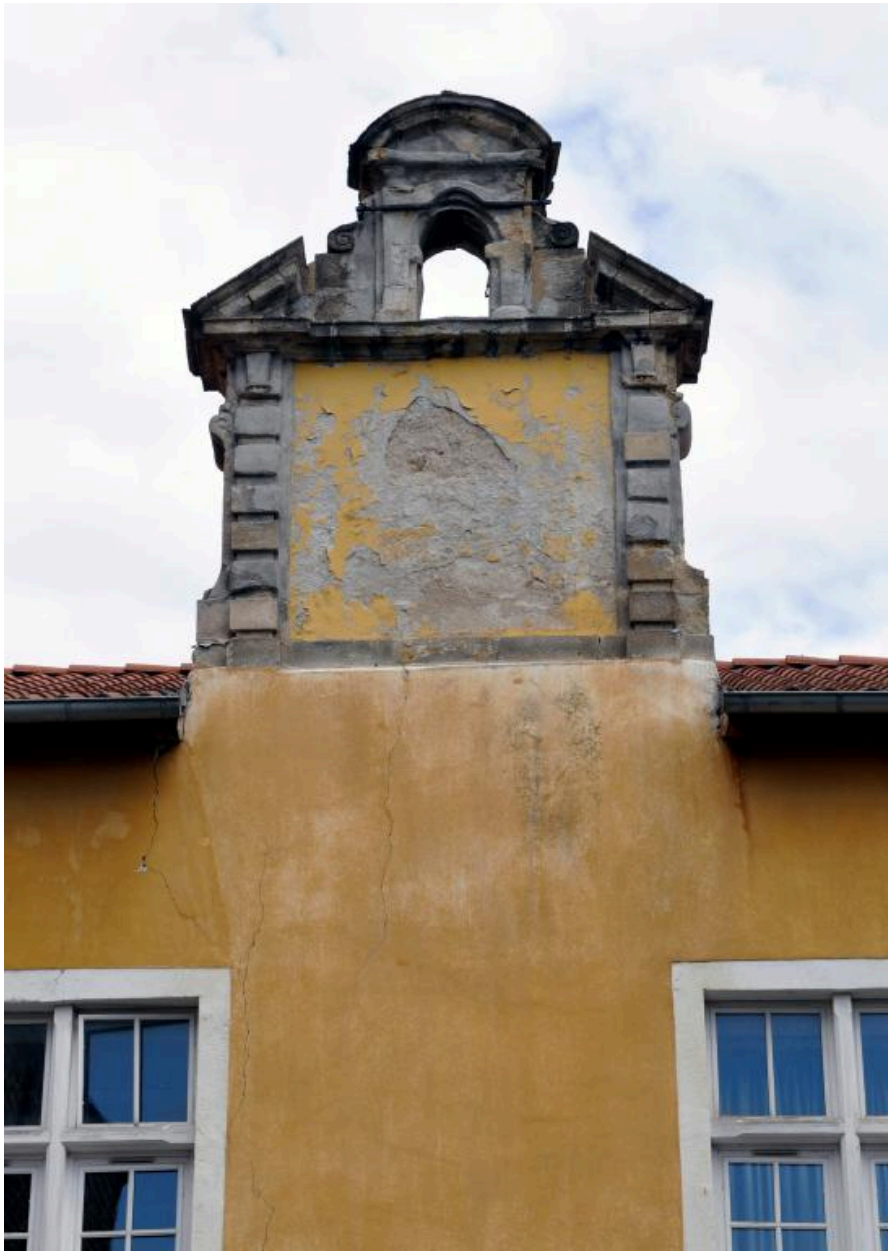
Bâtiment F : élévation sur cour 2, détail du fronton
