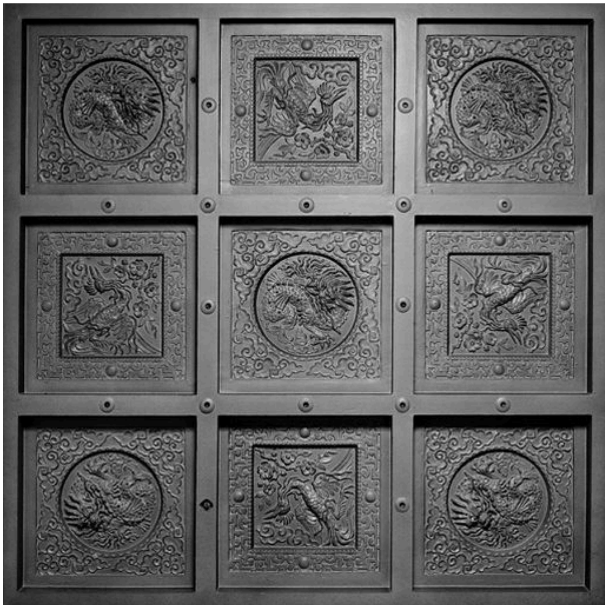
Plafond à caissons
