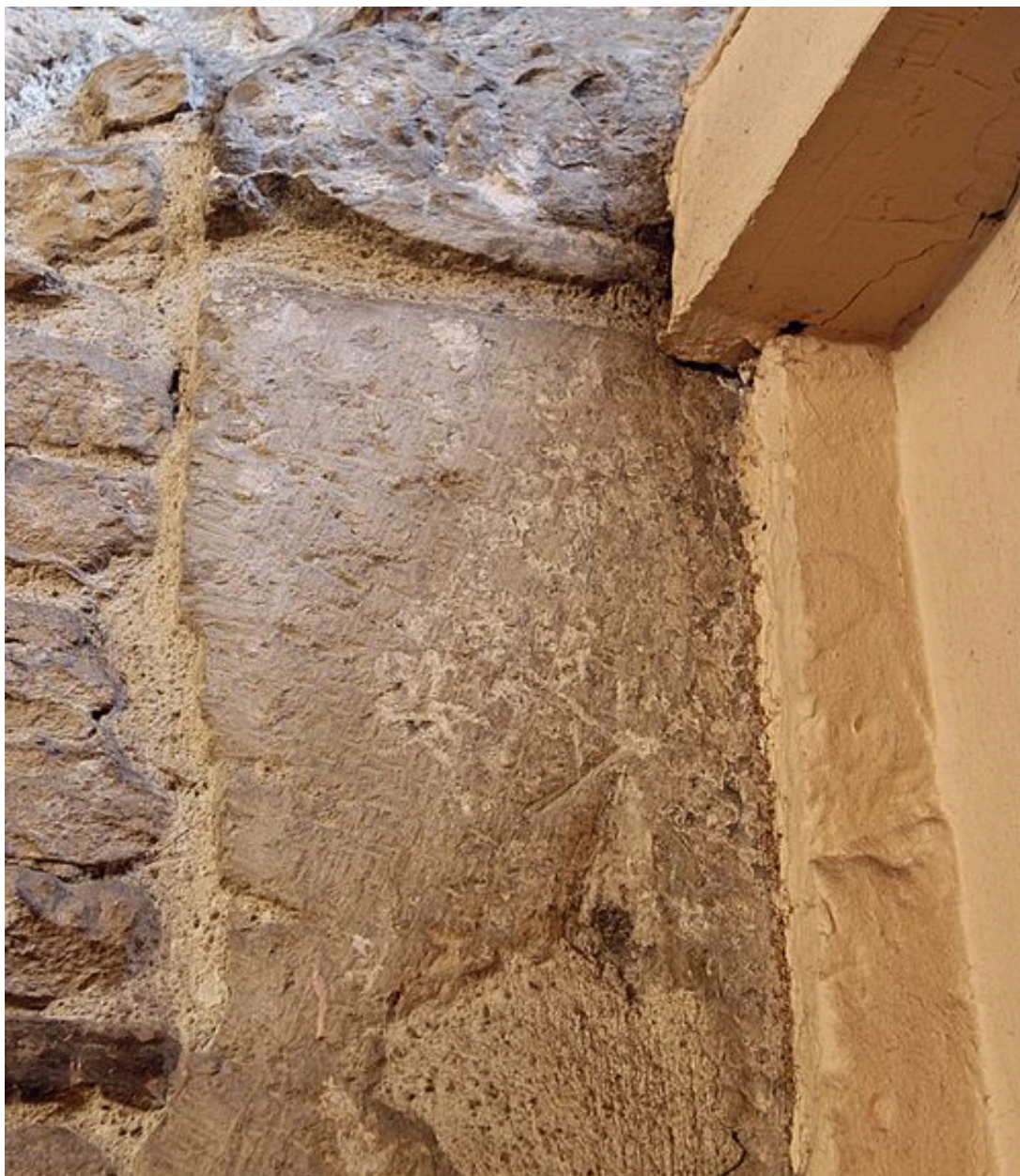
Marque de tâcheron au niveau du premier repos de l'escalier
