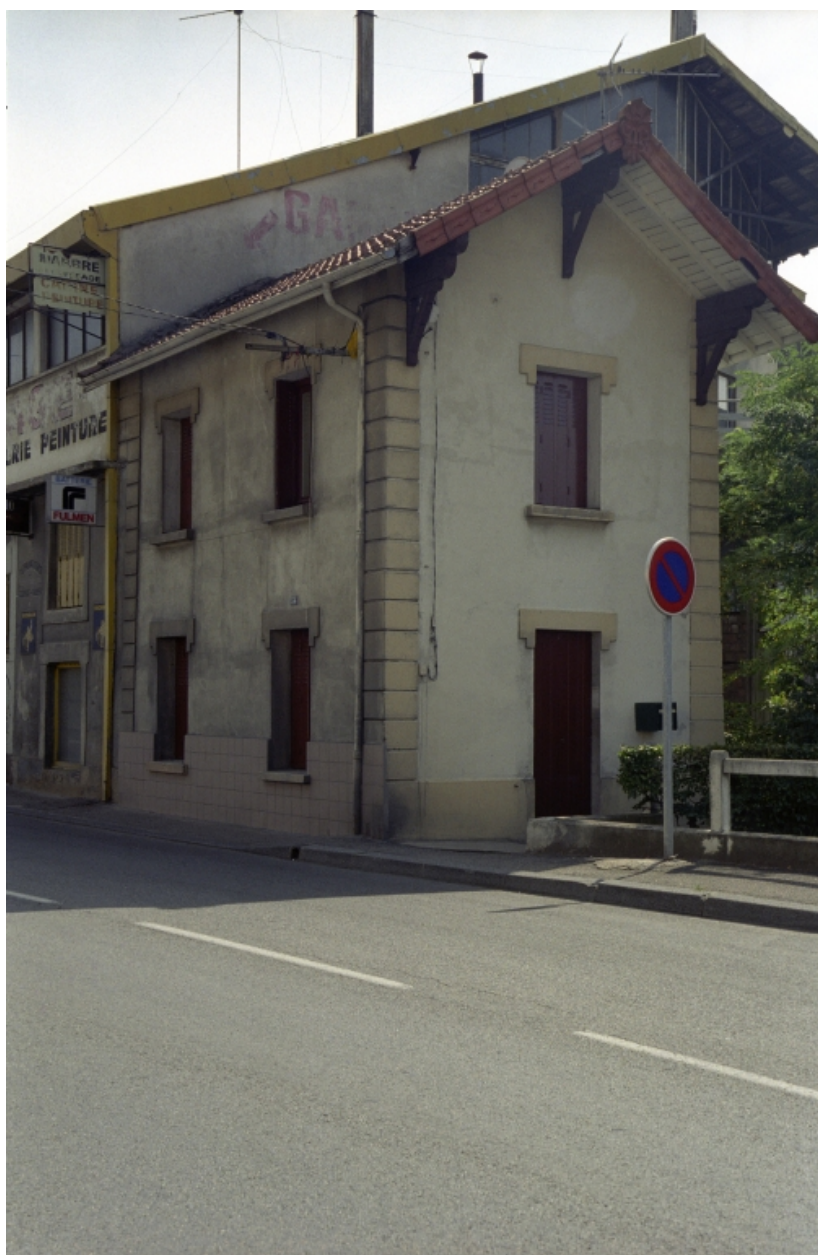
Boën, îlot 18, Lyon (rue de) 34. Vue générale de la façade sur rue.
