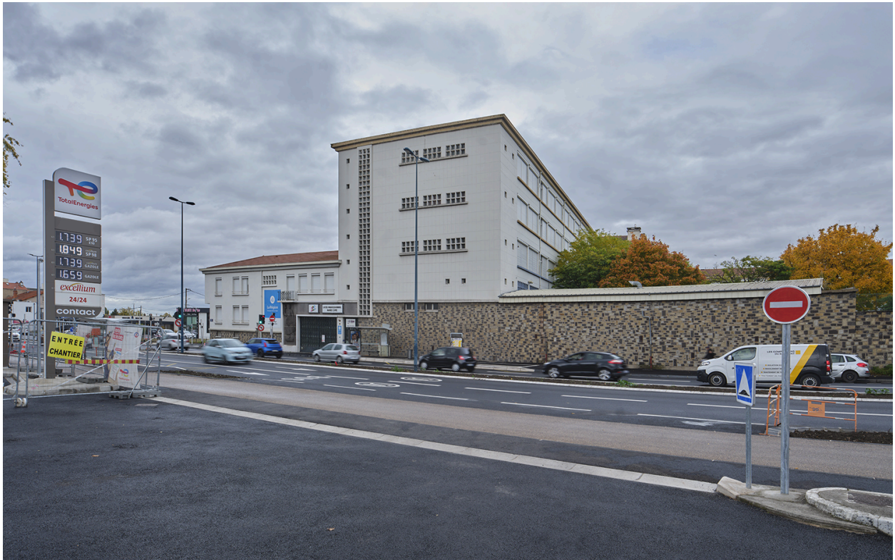
Vue générale depuis le sud
