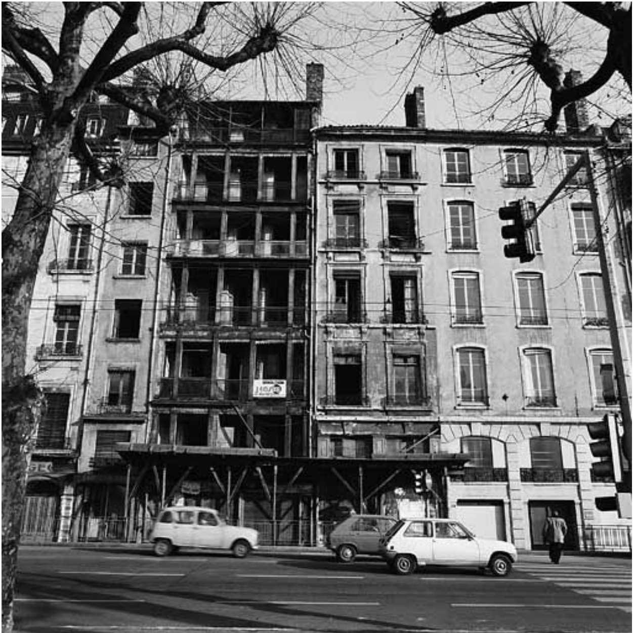
Façade quai Saint-Antoine
