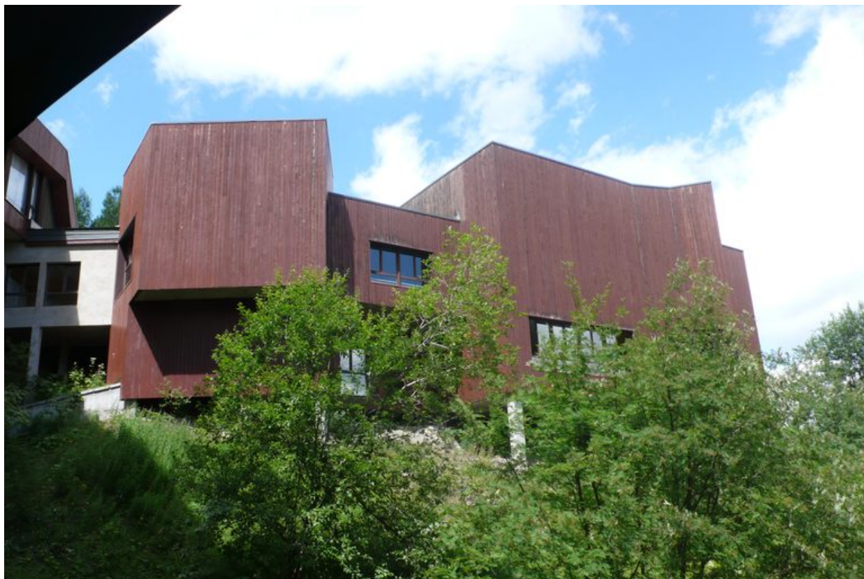
Bâtiment nord vu depuis l'est
