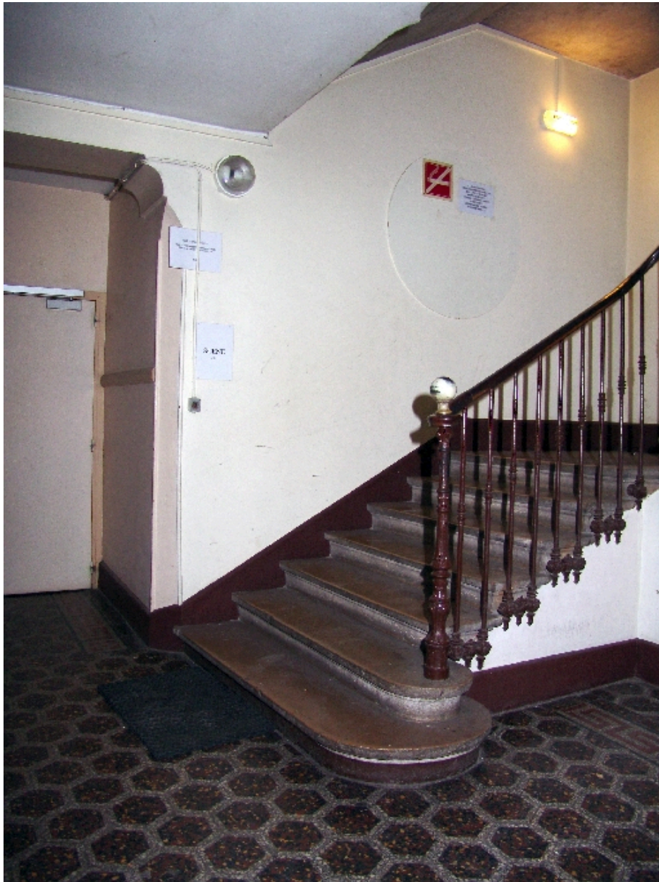
Escalier de service
