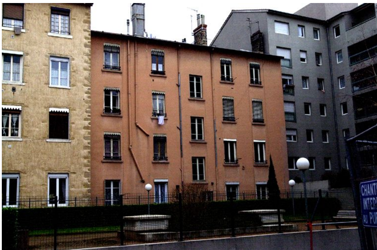
Elévation postérieure, depuis la rue Quivogne
