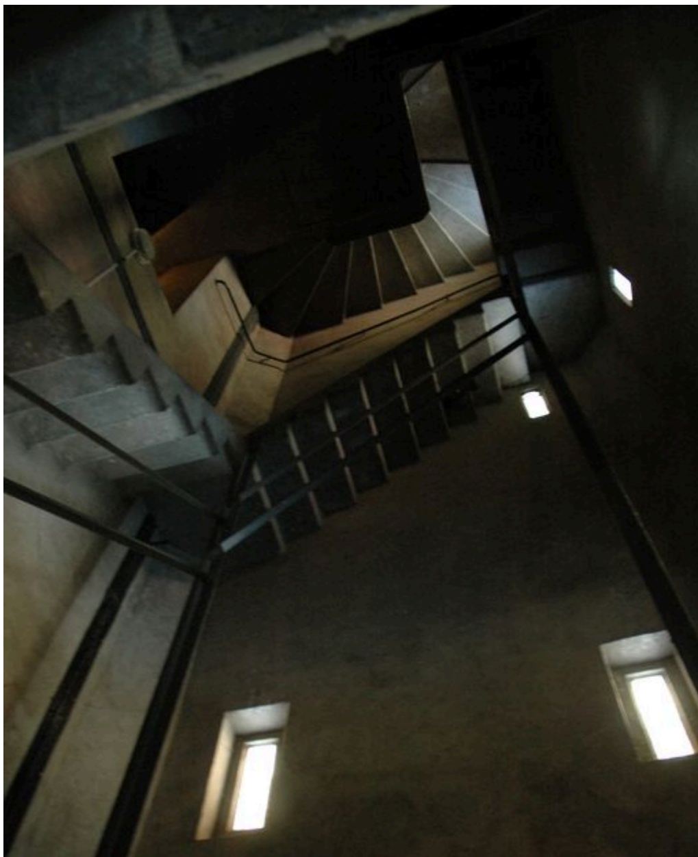
L'escalier du clocher
