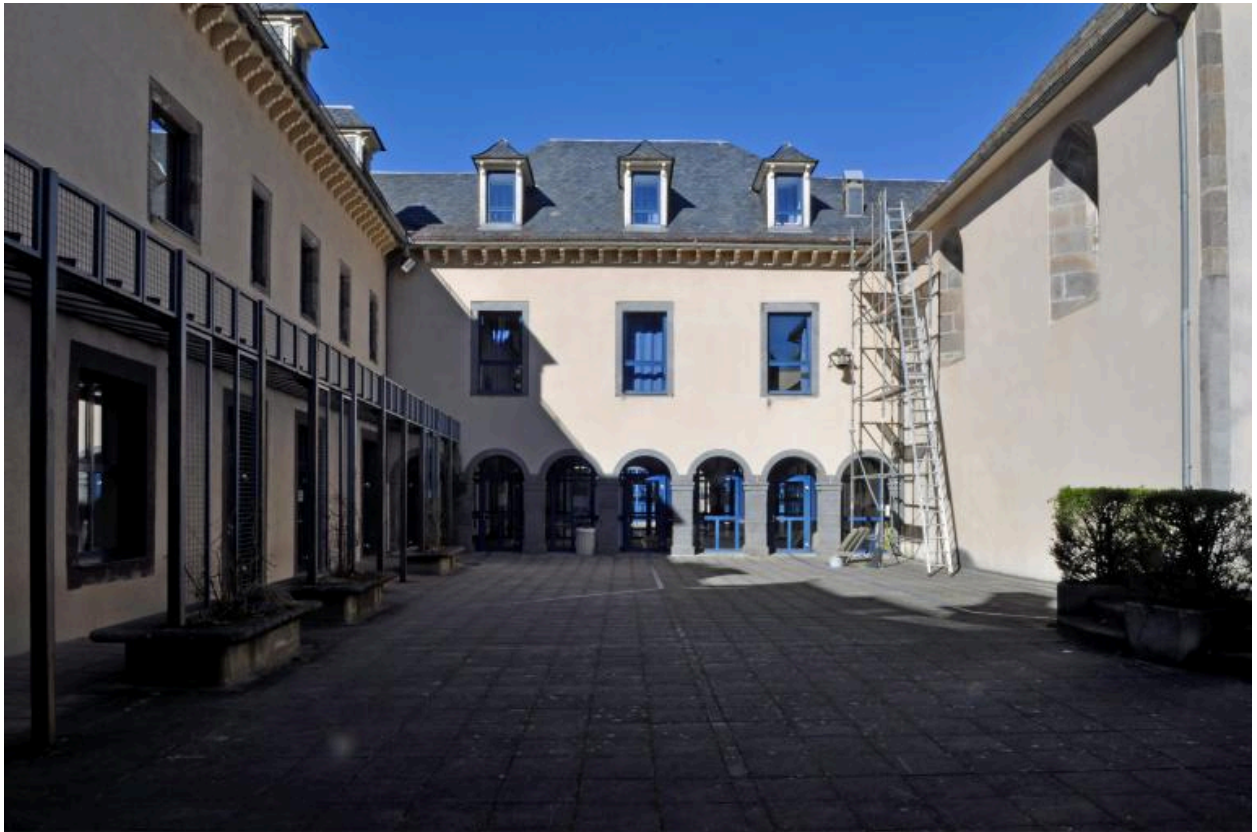
Cour sud, vue depuis le sud
