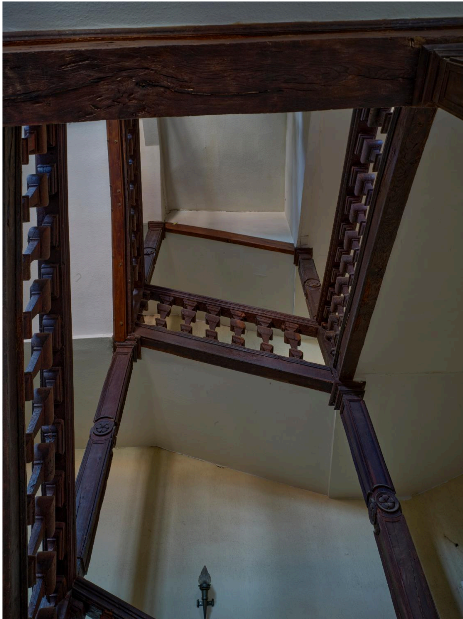
Aile est : cage de l'escalier
