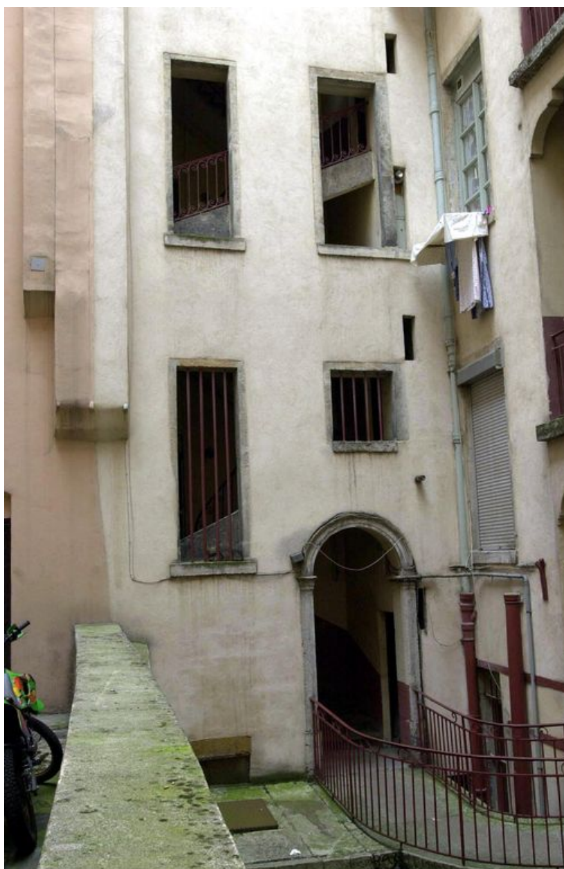
Cage d'escalier du corps en retour, étages inférieurs
