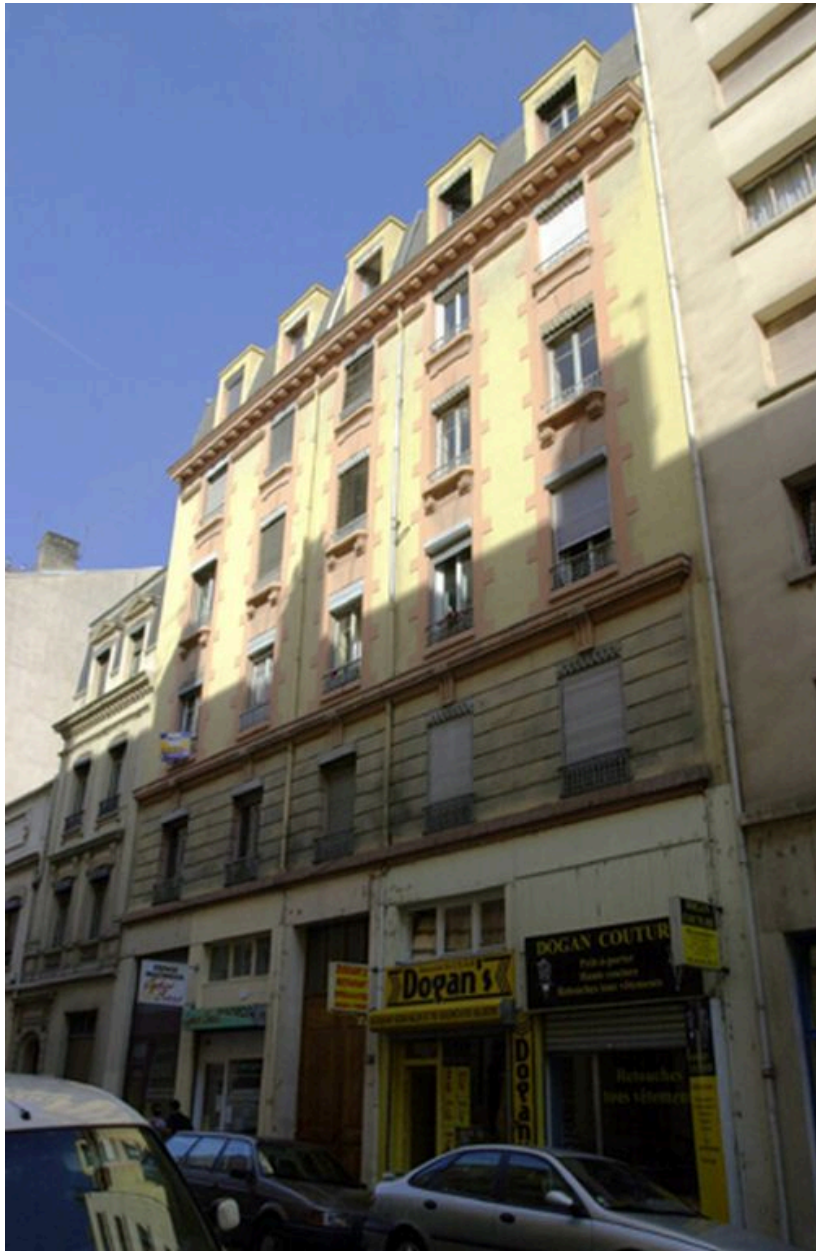
Elévation principale depuis le nord-est
