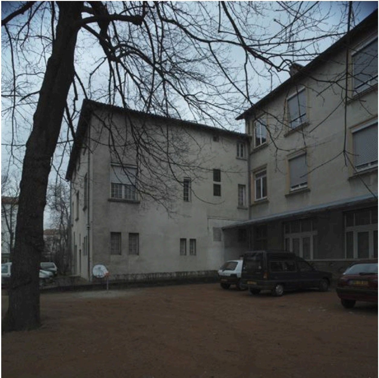
Logis, façade latérale sud
