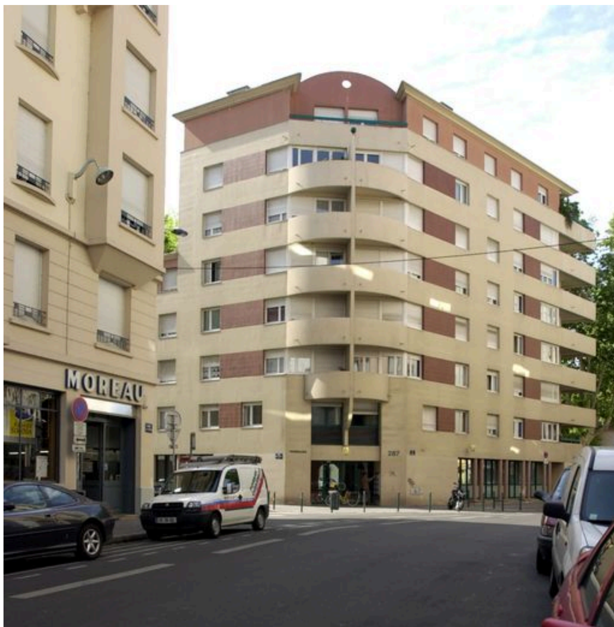
Vue générale depuis le nord-ouest
