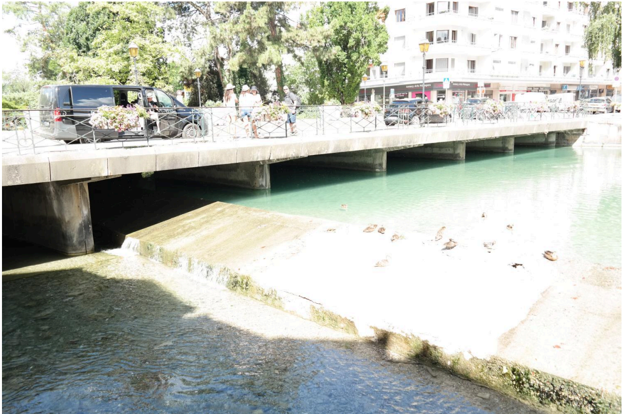
Pont rue de la gare, détail du tablier face amont
