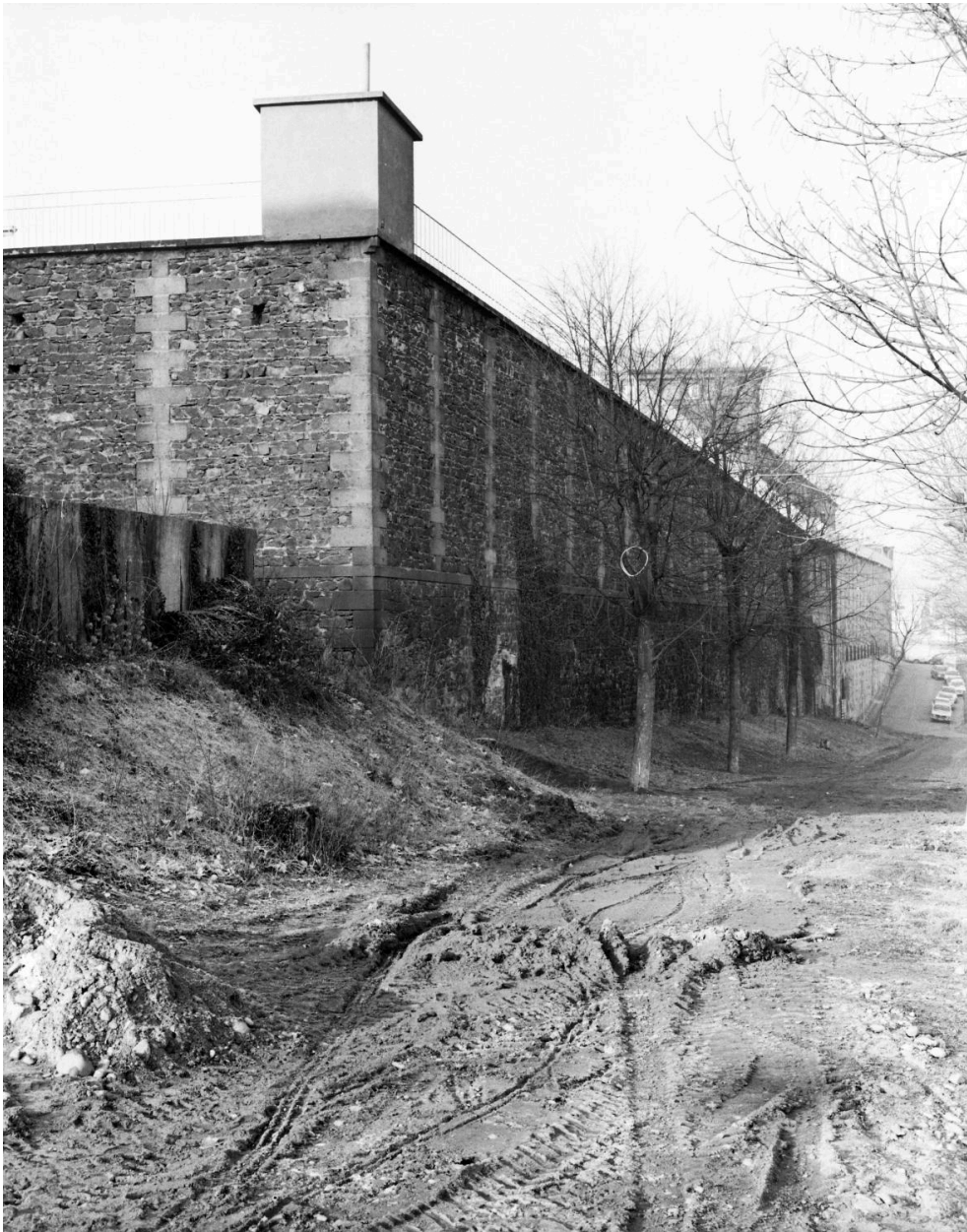
Vue du mur d'enceinte nord-ouest.
