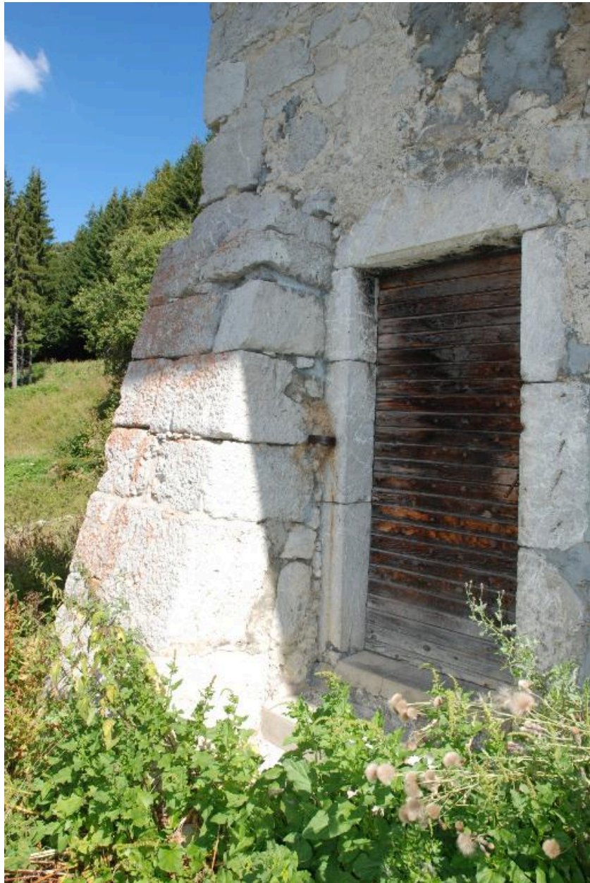
Détail d'un contrefort en façade.
