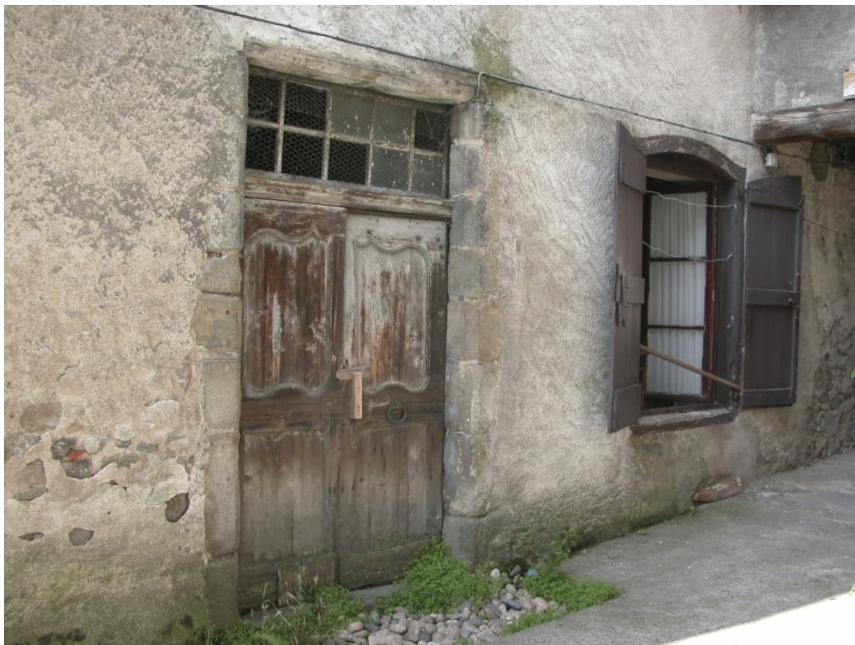
Îlot 2. Roanne (rue de) 11. Vue d'ensemble du rez-de-chaussée sur cour (parcelle 546)
