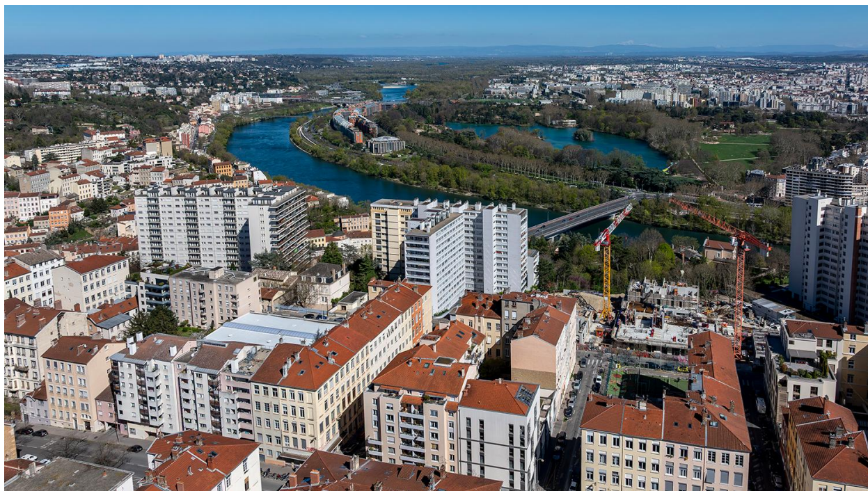
Vue d'ensemble secteur des immeubles-ateliers (vue drone)
