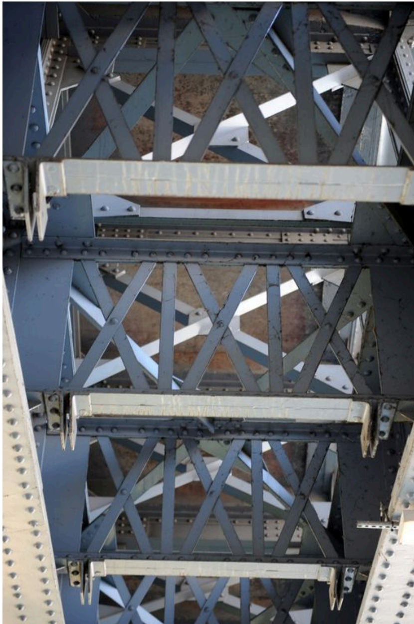
Arche, de dessous, vue de détail : assemblage de la structure métallique (depuis la rive gauche)
