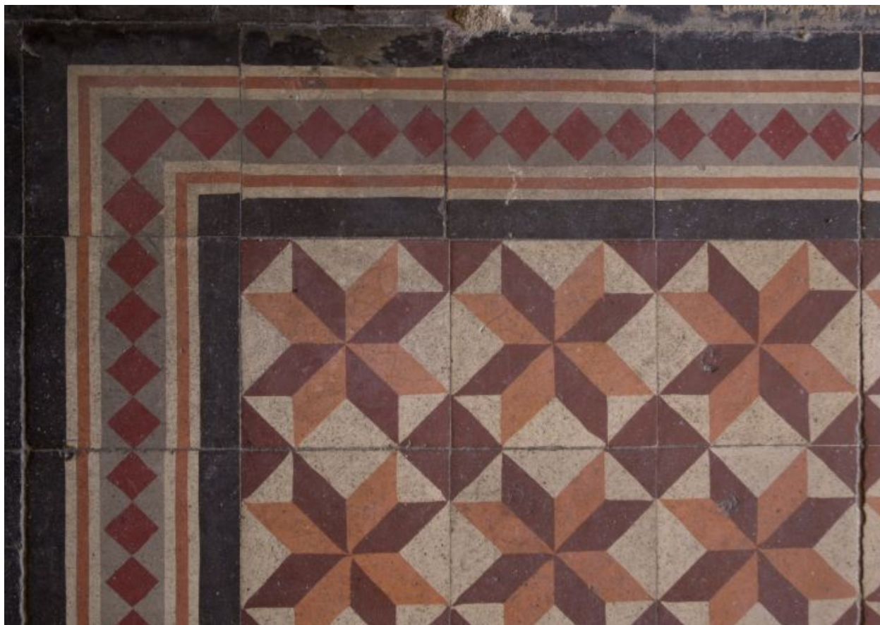
Détail du carrelage du vestibule, 83 quai Perrache
