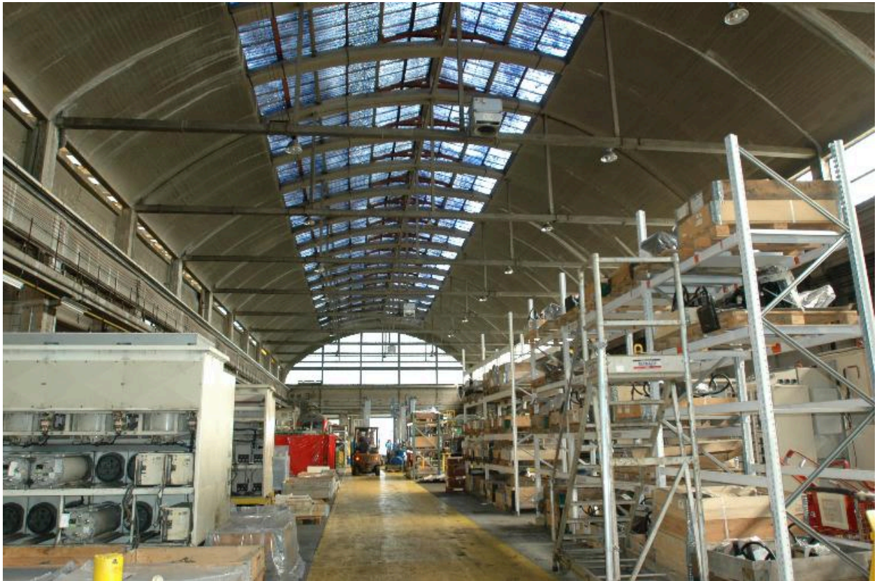
Vue intérieure des ateliers : charpente béton
