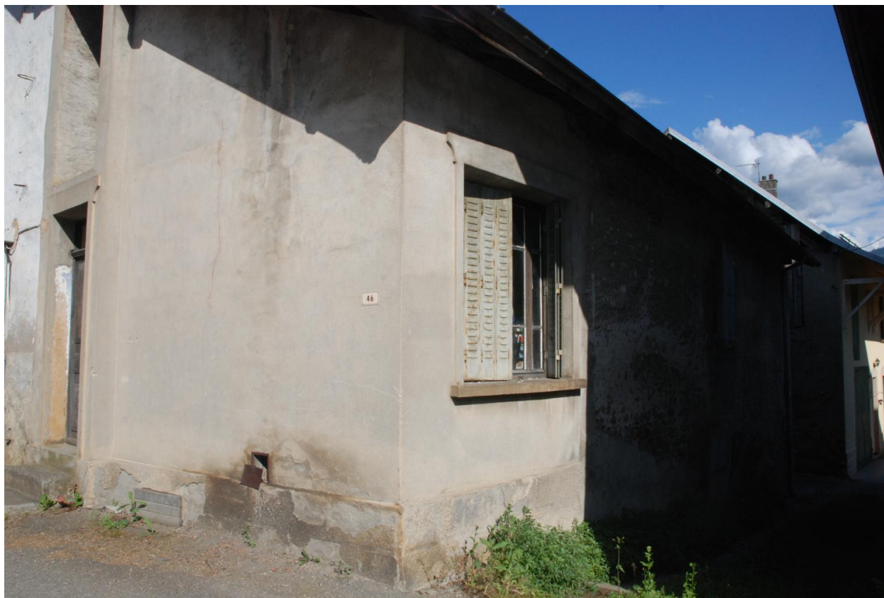
Maison (2018 D3 781 nord). Elévation sur la rue du Four.
