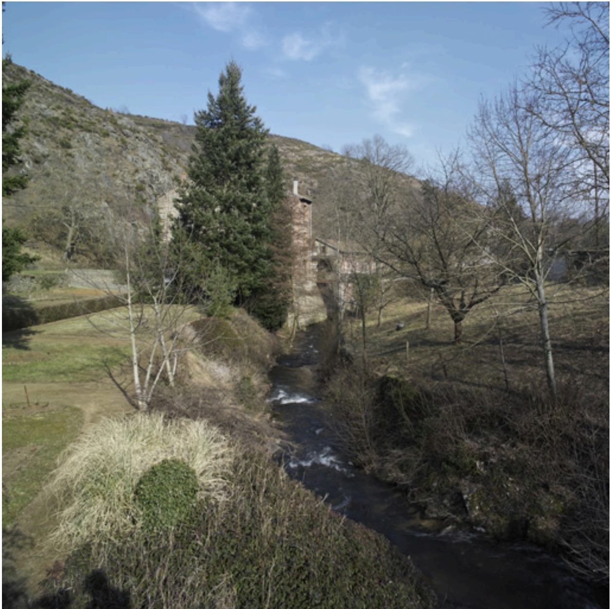
Vue générale du bief et du bâtiment d'habitation, depuis l'ouest.
