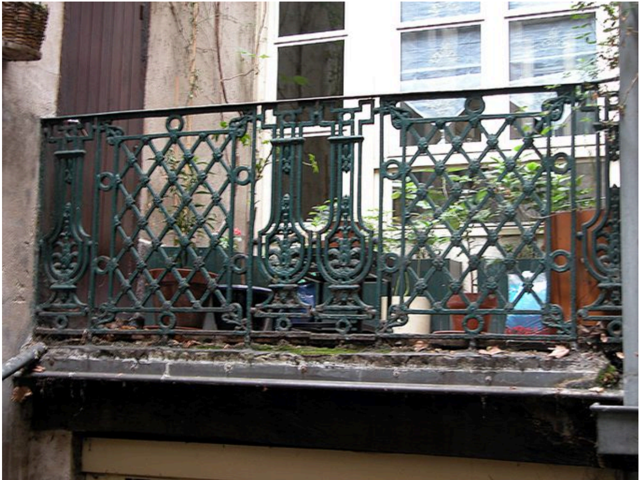
Garde-corps du dernier étage du corps de bâtiment ouest
