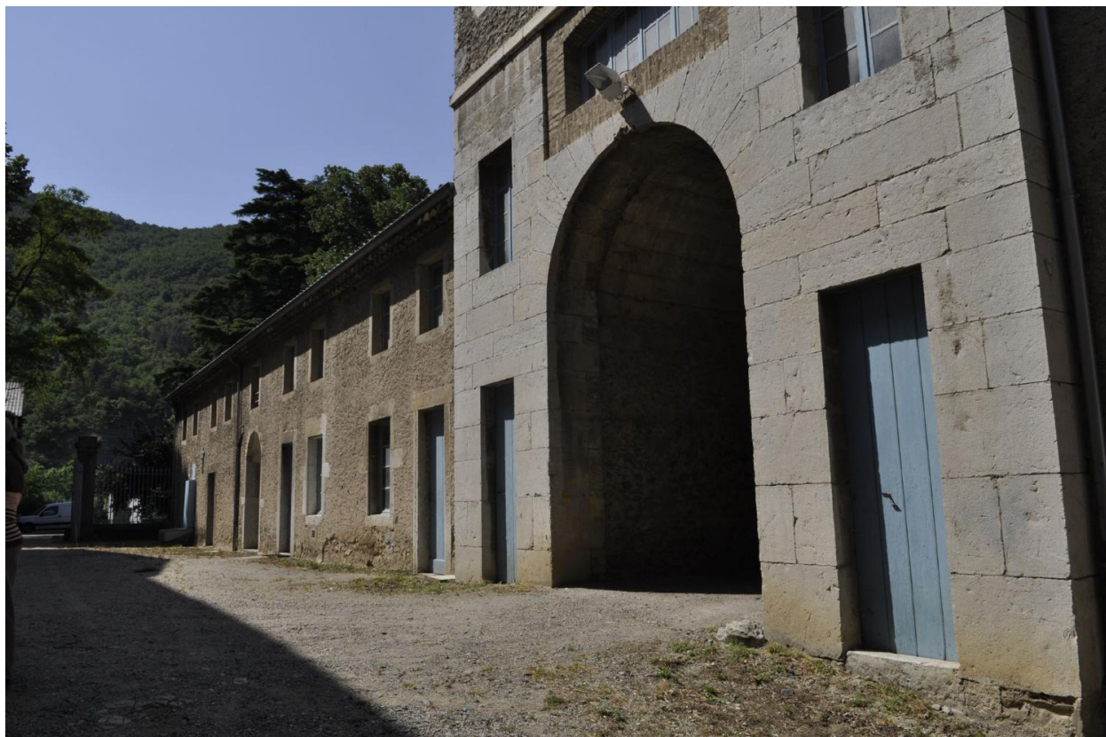
Passage : blocs calcaire, avec chaînages et encadrements
