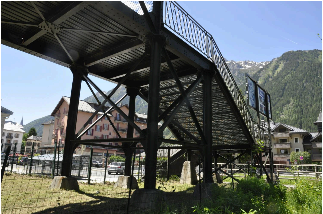
Vue de la passerelle : culée métallique faisant le lien avec l'escalier
