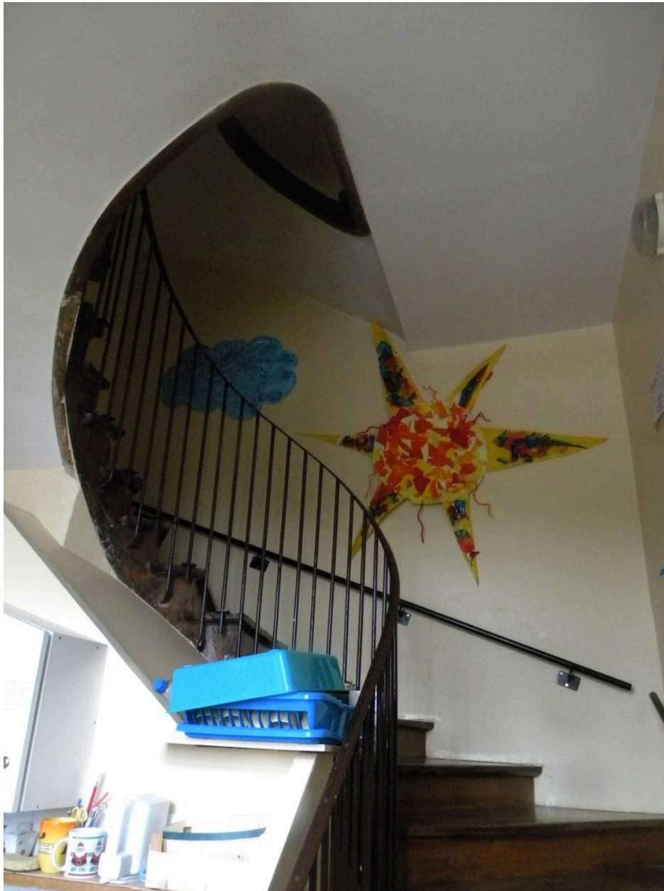
Escalier intérieur ouest vu par le bas.
