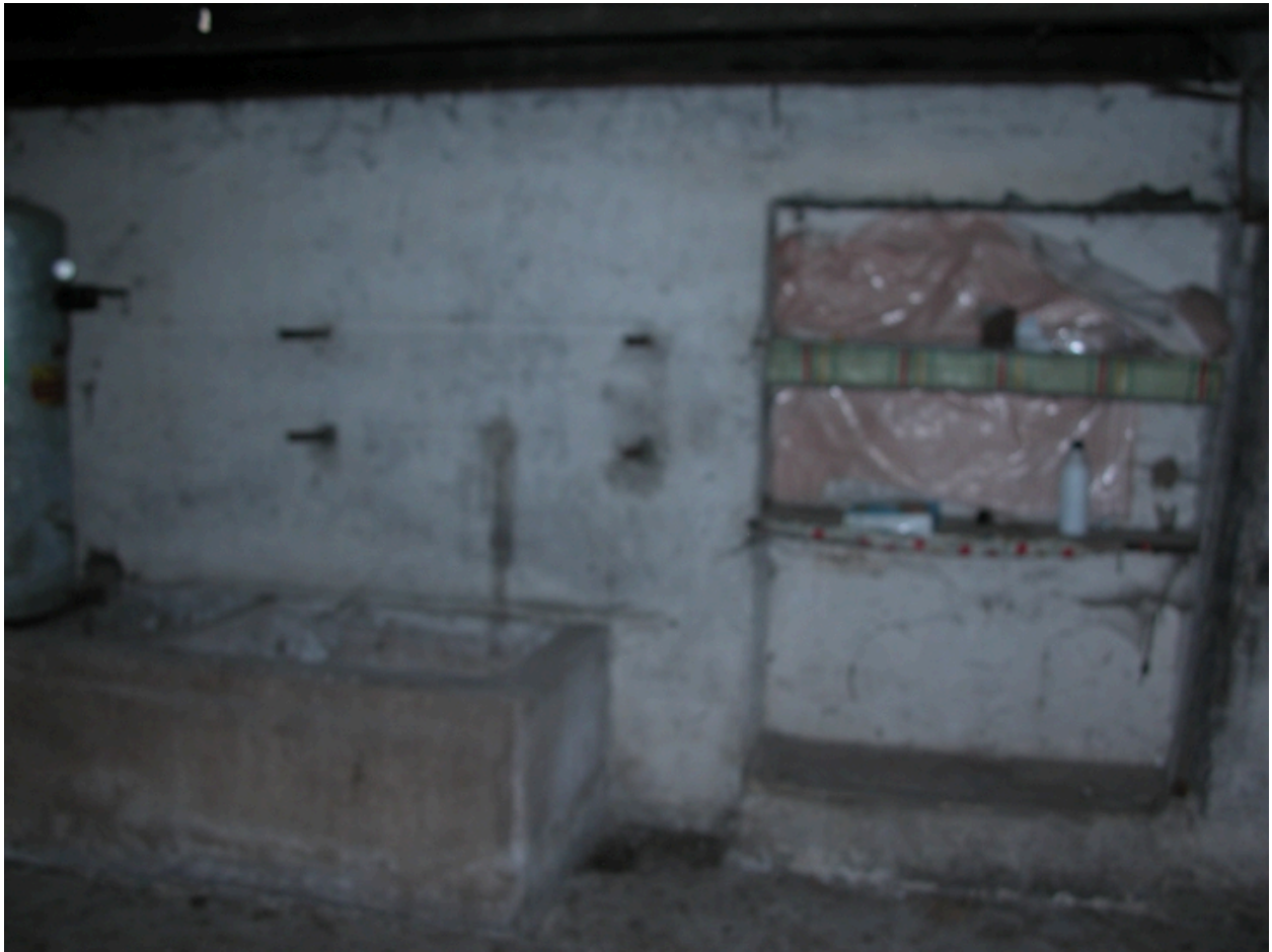
Vue intérieure de la laiterie.
