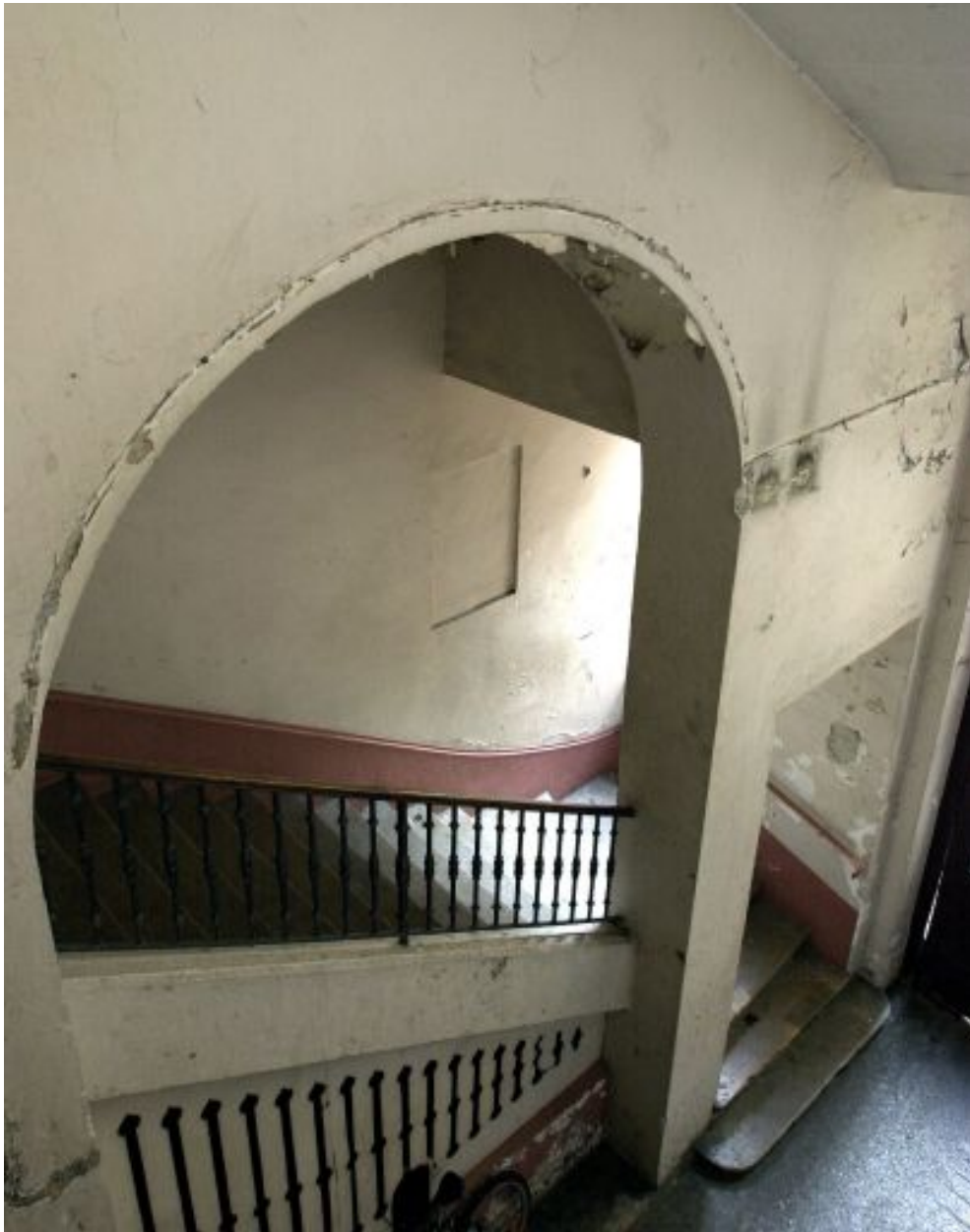
Vue de la 1ère volée d'escalier et de l'arcade du mur d'échiffre
