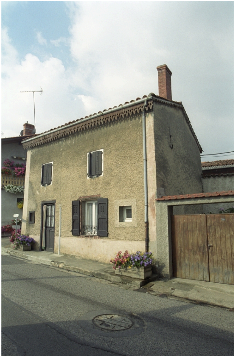
Ferme (A2 692), vue d'ensemble.
