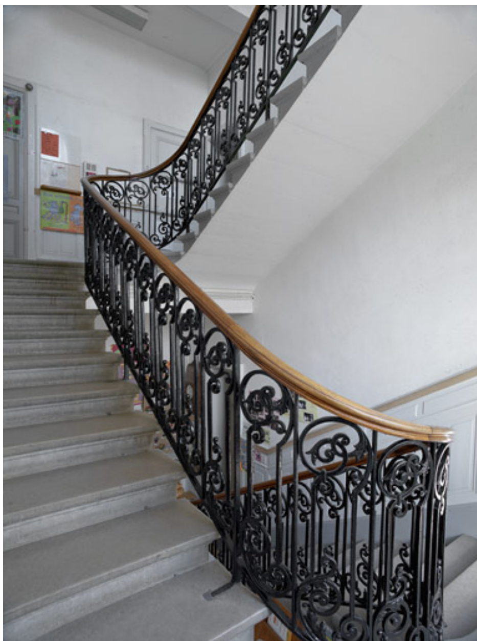
Escalier intérieur : rampe d'appui en fonte et main courante en bois.
