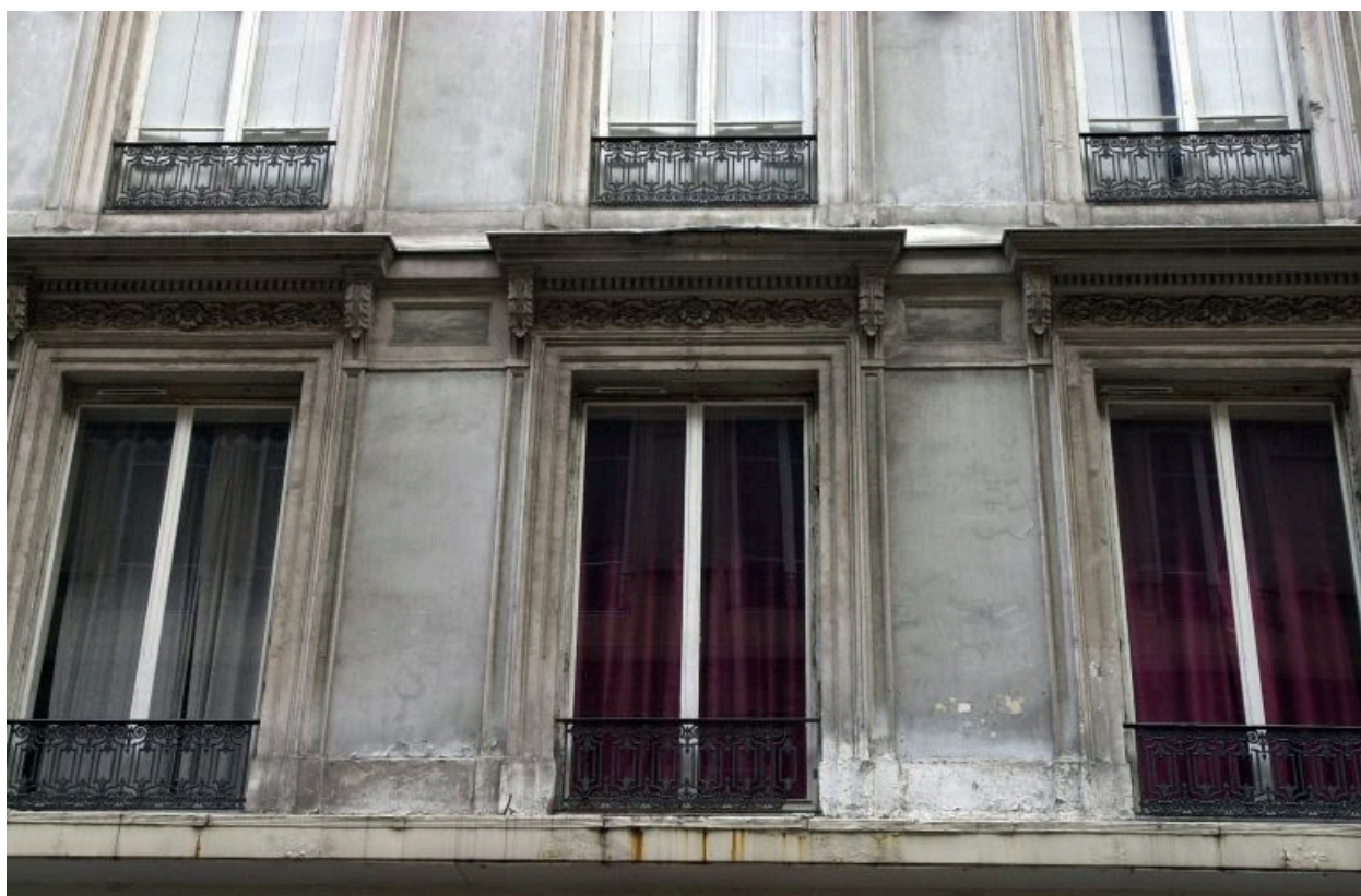
Façade, 2e niveau, détail des baies centrales
